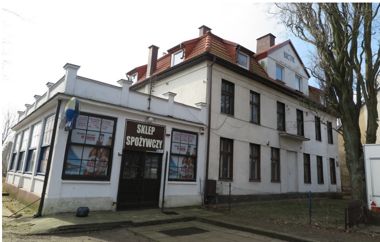
5. Budynek mieszkalny, ul. Orłowska 23
