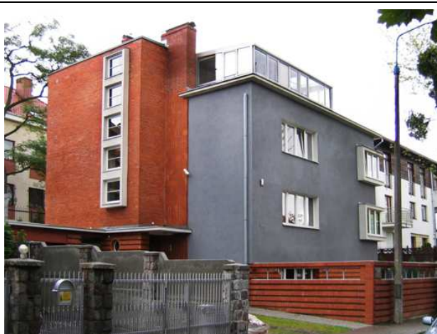
16. Willa modernistyczna M. Piotrowskiego
