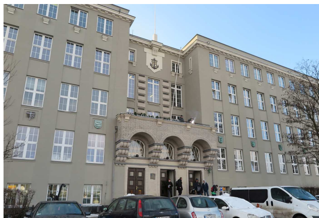
33. Zespół budynków dawnej Szkoły Morskiej, ob. Uniwersytet Morski
