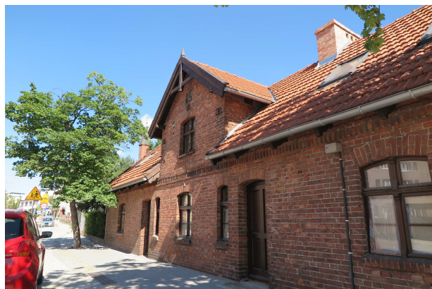
67. Budynek mieszkalny w Chyloni
