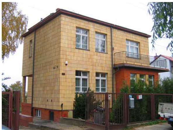
34. Willa modernistyczna w Orłowie
