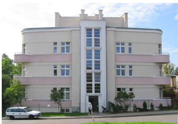
6. Dom mieszkalny „Opolanka”
